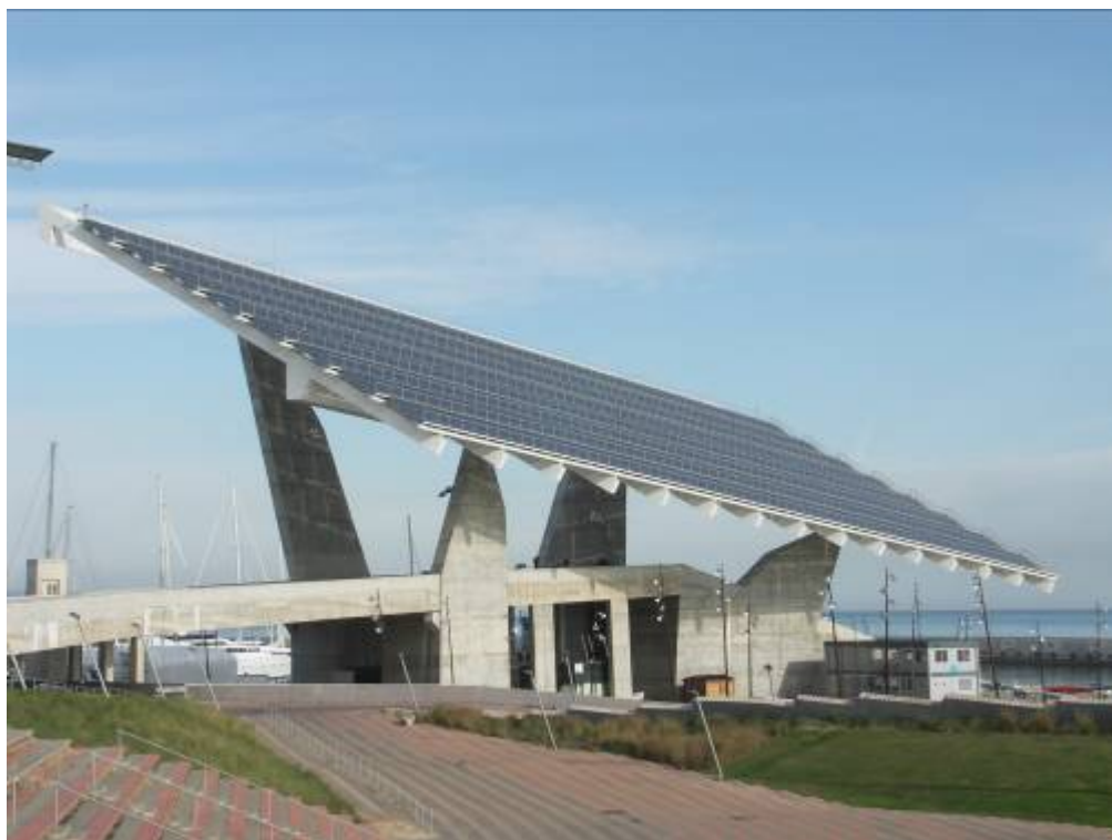
« La pergola », près du port du Forum entièrement recouverte de panneaux photovoltaïques
