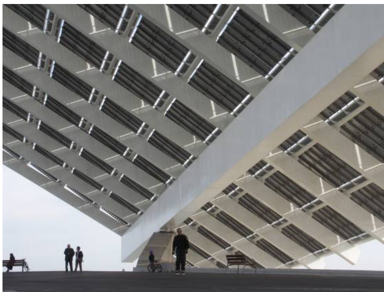
La Pergola, Centrale solaire photovoltaïque sur le port de Barcelone
