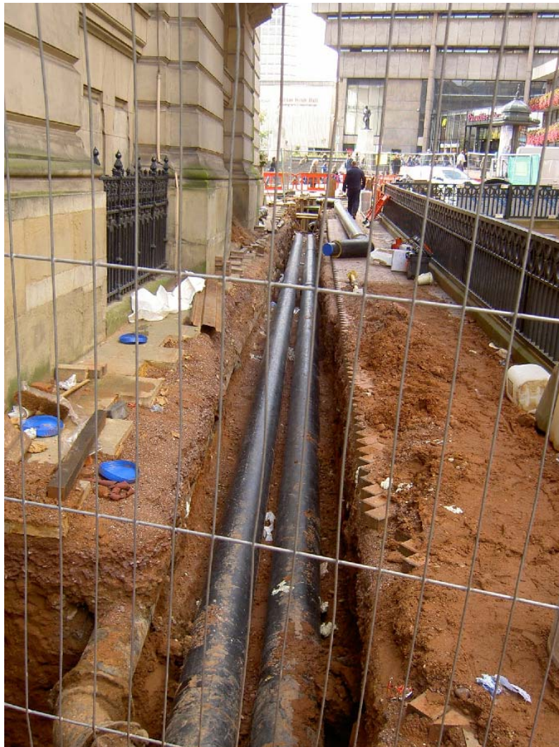
Figure 4 : Distribution hydraulique du MRC à Birmingham (source : Courtesy of Energ)
