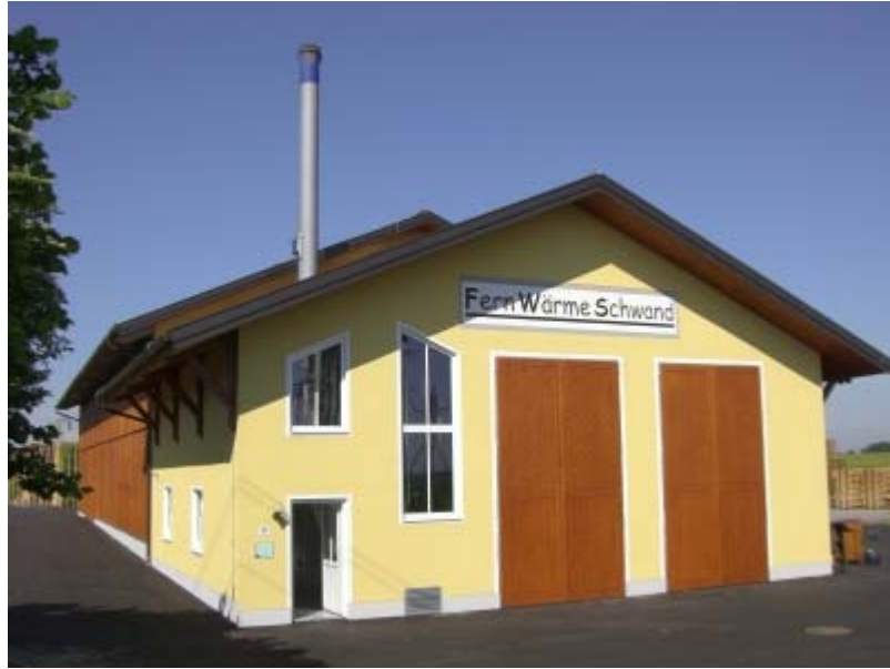
Figure 3 : Centre de production de chaleur de 1MW à Schwand / Autriche (source : http://www.biomasseverband-ooe.at )
