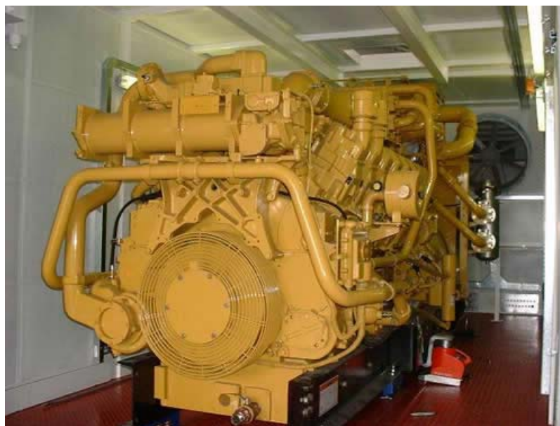
Figure 2 : Système de cogénération pour un MRC de 1 MWe (source : Courtesy of Energ)
