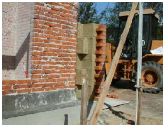
Figure 1 : travaux en cours de mise en œuvre d'un mur double sur un bâtiment existant avec une épaisseur d'isolant de 250mm (source DTU [3])
